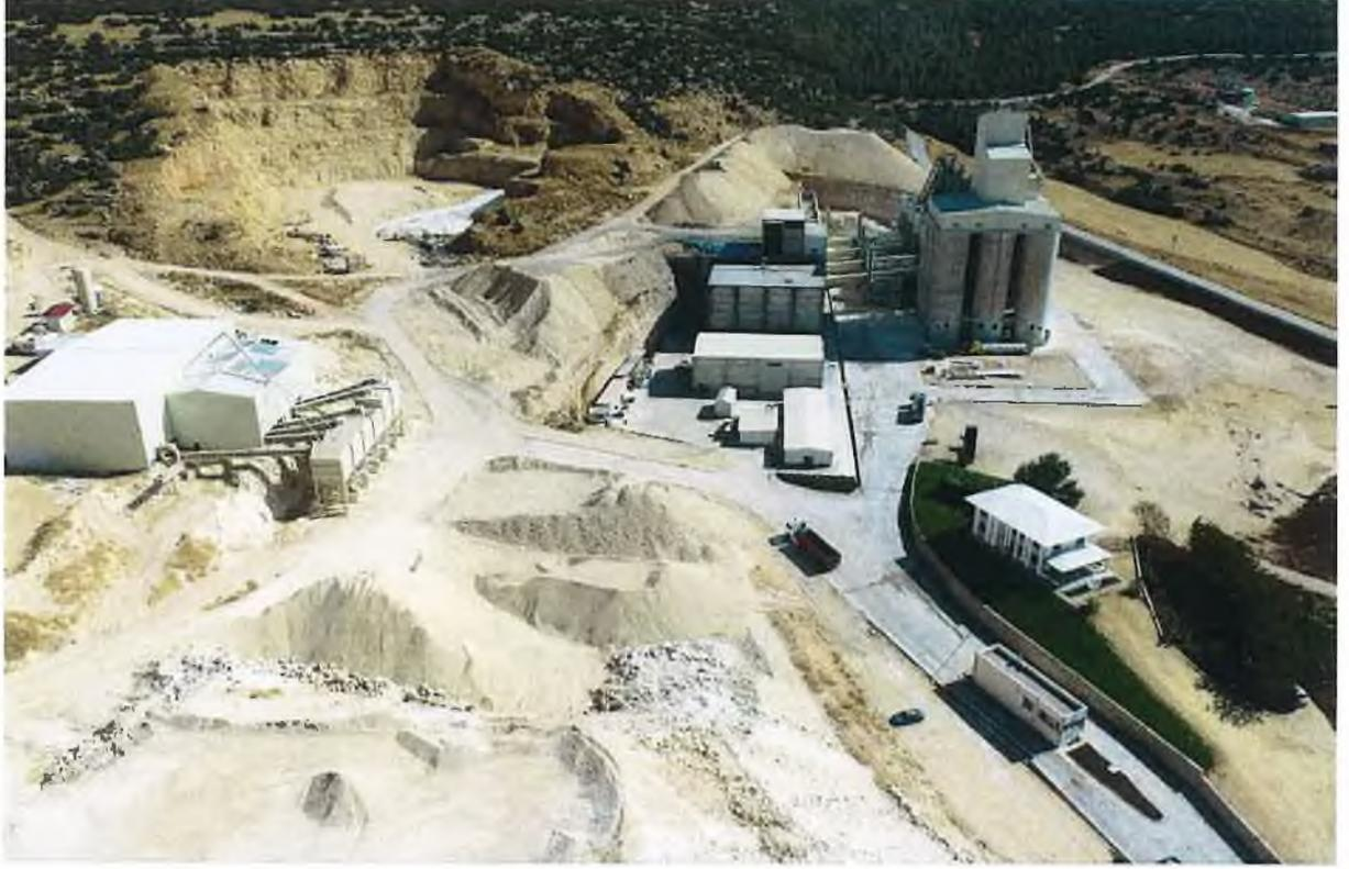
Narlı Fabrikası bünyesinde agrega dışında üretilen ürünler, her boyutta 1000 ton kapasiteli bağımsız silolarda sevk edilmek üzere stoklanmaktadır. Agregaya ise damperli (dökme) kamyonlar ile sevk edilmektedir. İşbu izahname tarihi itibarıyla Narlı Fabrikası bünyesinde 9000 tonluk ürün silosu yanında 3000 tonluk elenmemiş malzeme stoğu bulunmaktadır.
