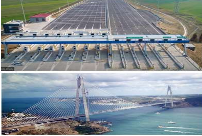
Kuzey Marmara Otoyolu Projesi
